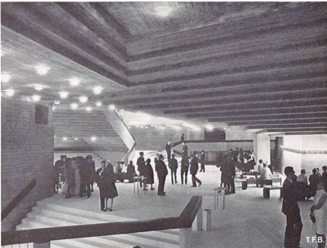
6 Le foyer avec, à l'arrière, l'escalier d'accès à la salle
