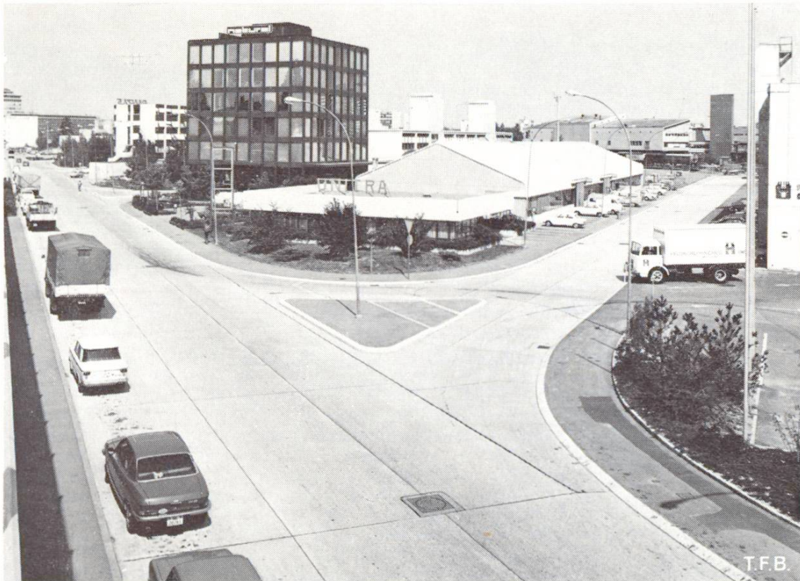
Fig. 7 Dans l'aménagement de La Praille à Genève, cette artère bétonnée, avec ses embranchements en doigts de gant a été construite en terrains vagues. Ce n'est qu'ensuite que se sont érigés les bâtiments.
