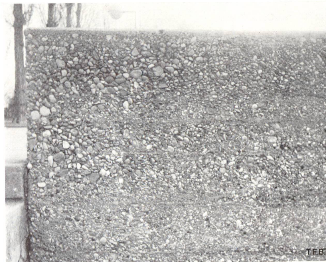
Fig. 9 et 10 Petit mur en béton lavé faisant partie d'un aménagement scolaire à Zurich et pleinement soumis aux intempéries. Photos de 1962 et 1972. Ces vues infirment l'opinion générale voulant que le béton lavé soit particulièrement sensible au gel. Il est vrai qu'aujourd'hui, après 10 ans, les grains sont un peu plus dégarnis, mais aucun d'eux n'a été arraché. La couverte en mortier, elle aussi, s'est très bien comportée, mieux que le crépissage latéral des marches d'escalier.
