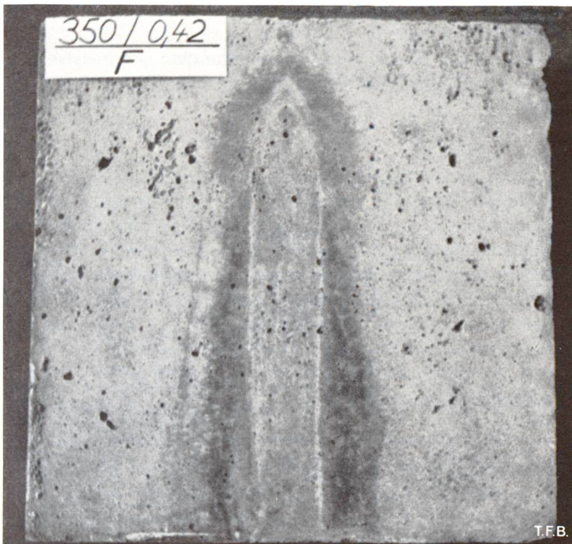
Fig. 3 Etude du comportement de la teinte grise d'un béton fraîchement décoffré sous l'effet d'eau courante. Dans la région qui a été en contact avec l'eau en mouvement, la teinte est un peu plus foncée que dans les régions restées sèches. Entre les deux se trouve une zone particulièrement sombre qui était recouverte d'un film d'eau immobile.
