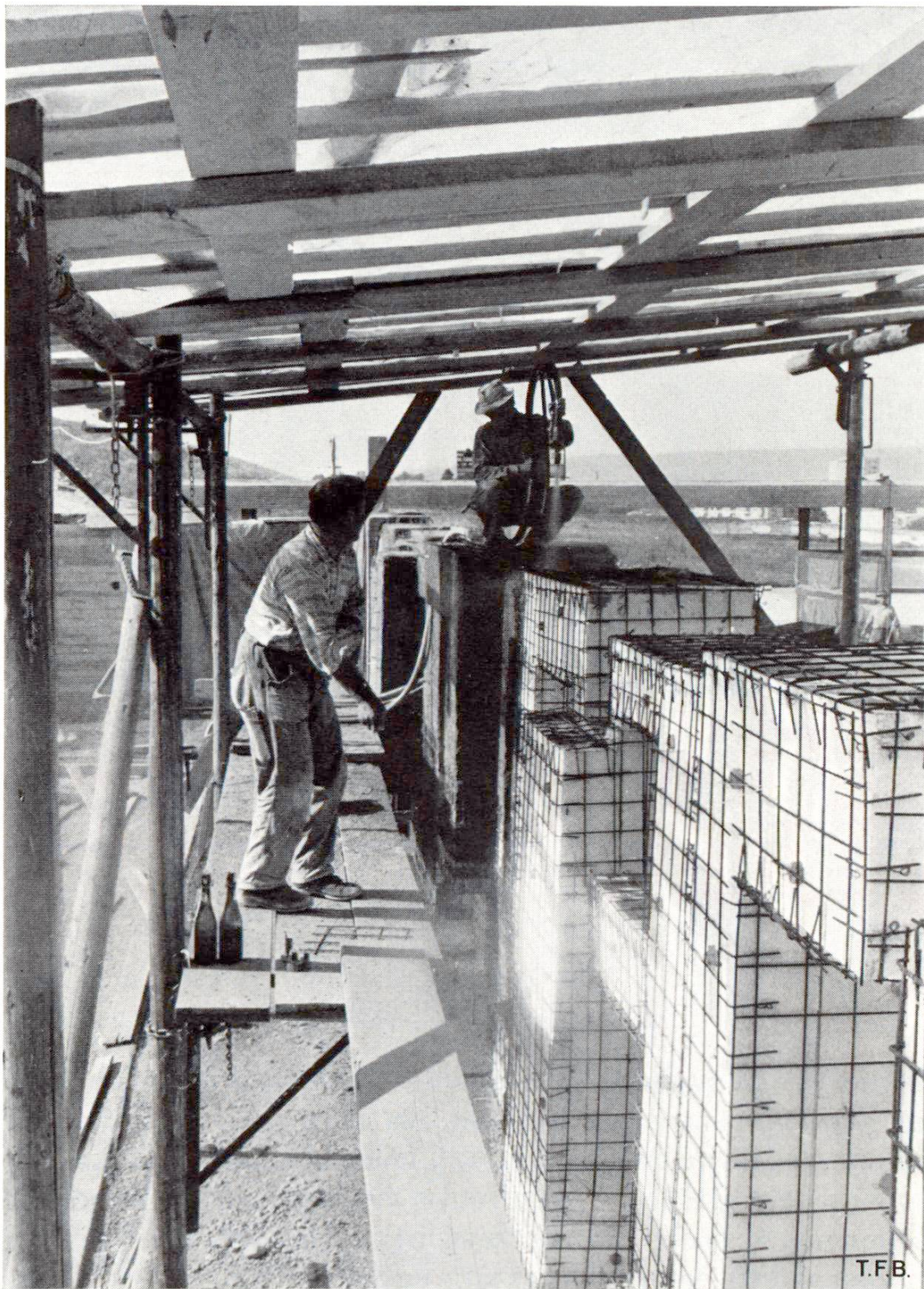
Fig. 2 Mur avec reliefs artistiques. Noyau en blocs de mousse synthétique de forme conve- nable. Armature en treillis d'acier à 2 cm du support.
