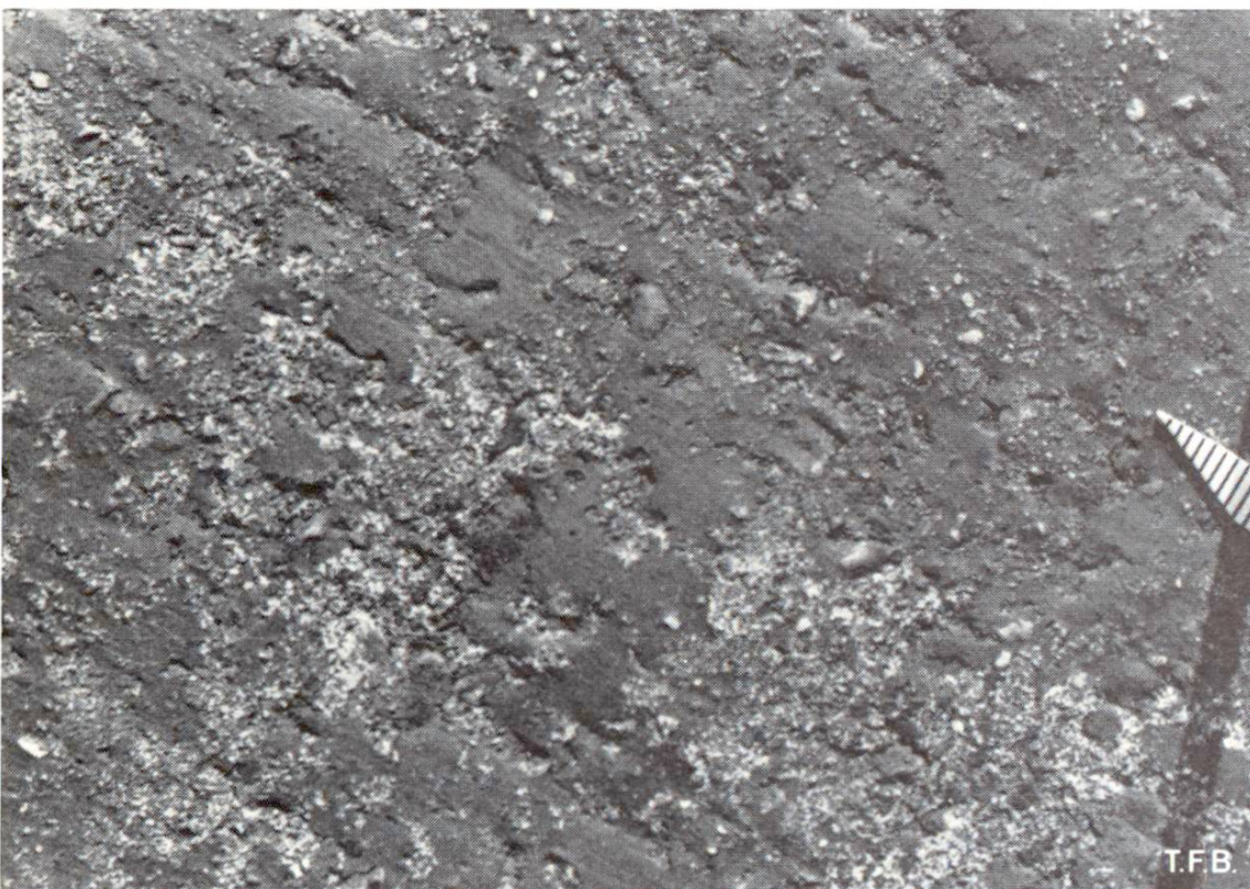
Fig. 5 Faible dépôt de caoutchouc sur une surface de béton qui n'exige pas encore un traitement (échelle millimétrique à droite).
