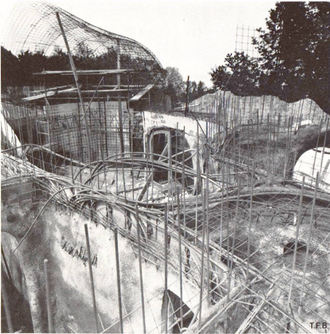
Fig. 2 Vue générale de la construction et de l'installation du second œuvre.
