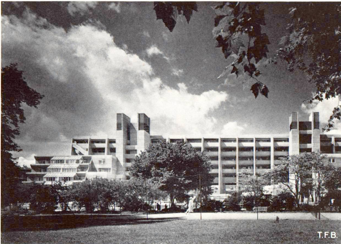
Fig. 2 Environ \frac{1}{3} de la façade longitudinale vue du «Brunswick Square Gardens», parc se trouvant à l'angle sud-est de l'aménagement.
