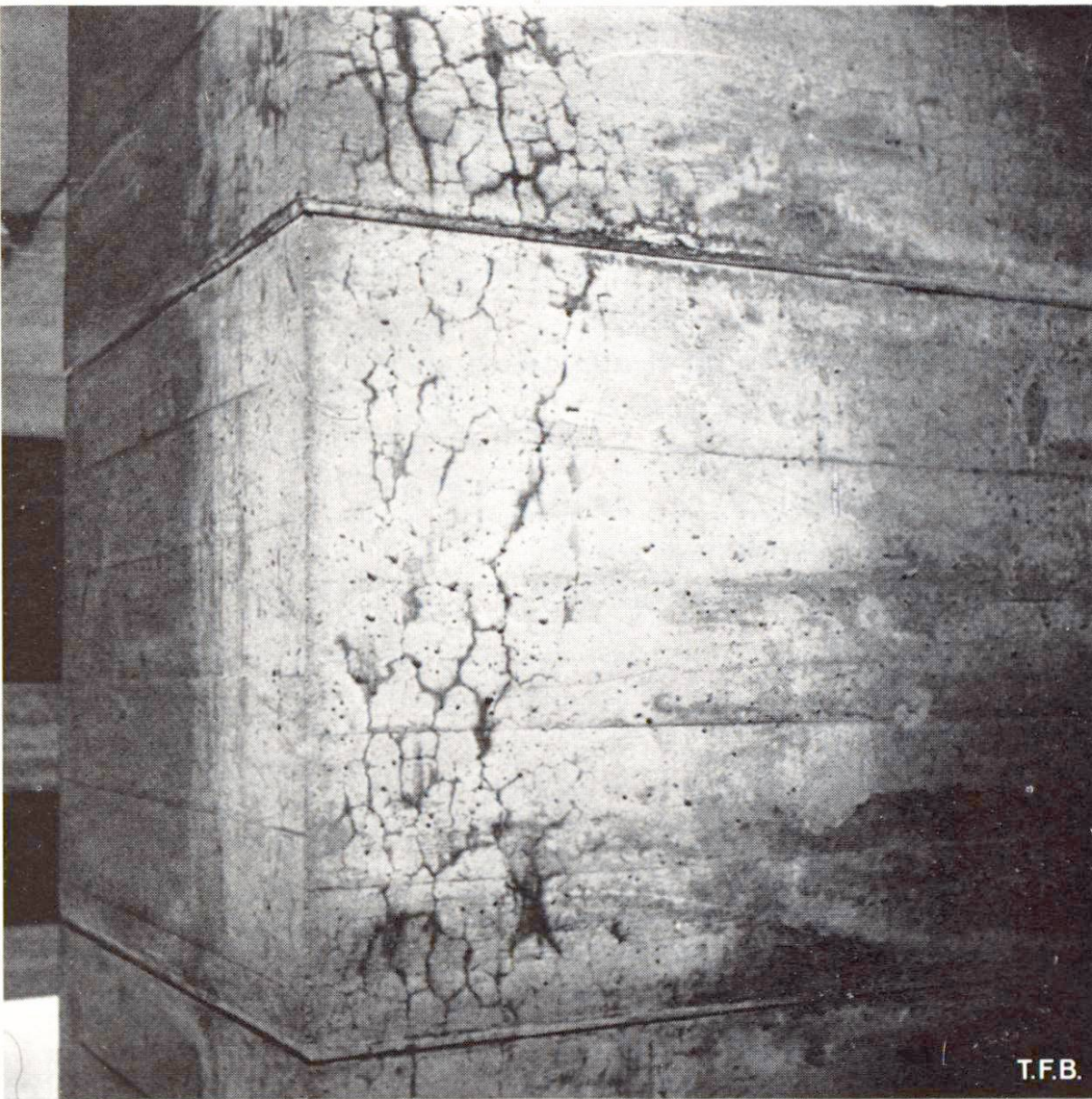
Fig. 5 Fissures à la surface d'une partie saillante. Elles sont dues à un dessèchement rapide peu après le décoffrage. Espacement des fissures 50-70 mm.
