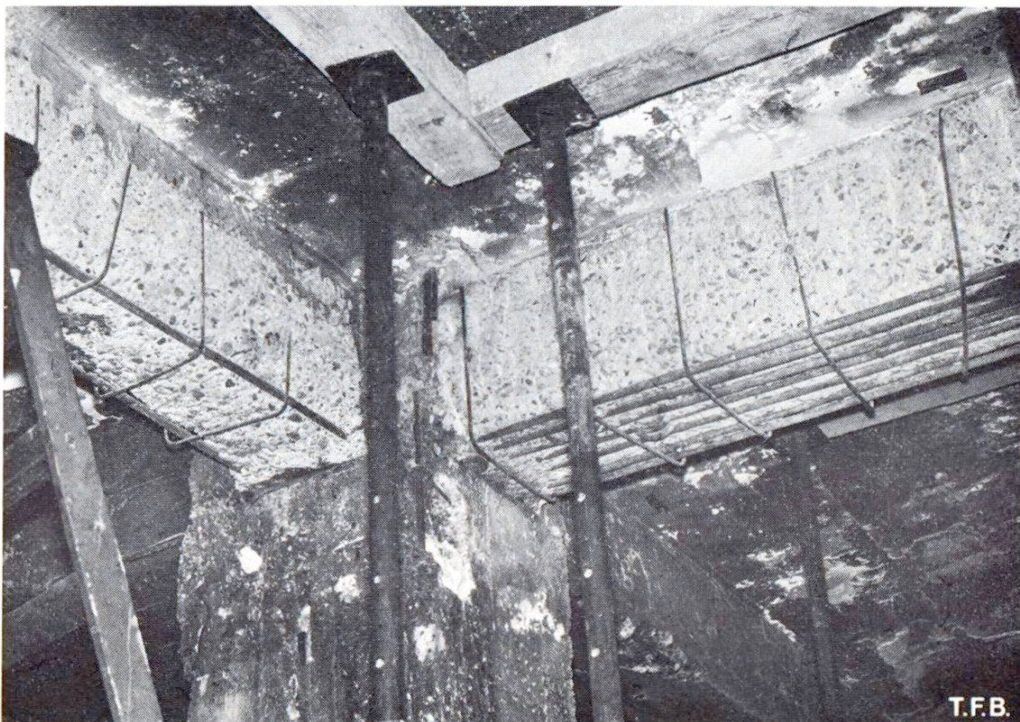
Fig. 4 Les sommiers, débarrassés de la zone superficielle altérée, ont pu être remis en état par recharge, en utilisant des coffrages métalliques appropriés (Fig. 5 et 6).
