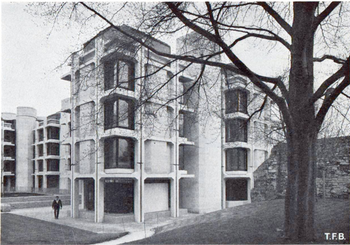
Fig. 2 De vieux murs restent à côté des nouveaux. Les cages d'escalier sont revêtues extérieurement de plaques de béton lisse.
