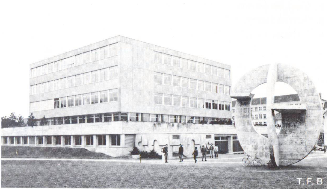
Fig. 1 Ecole professionnelle à Limmattal avec béton apparent classique et plaques de façade à texture striée.
