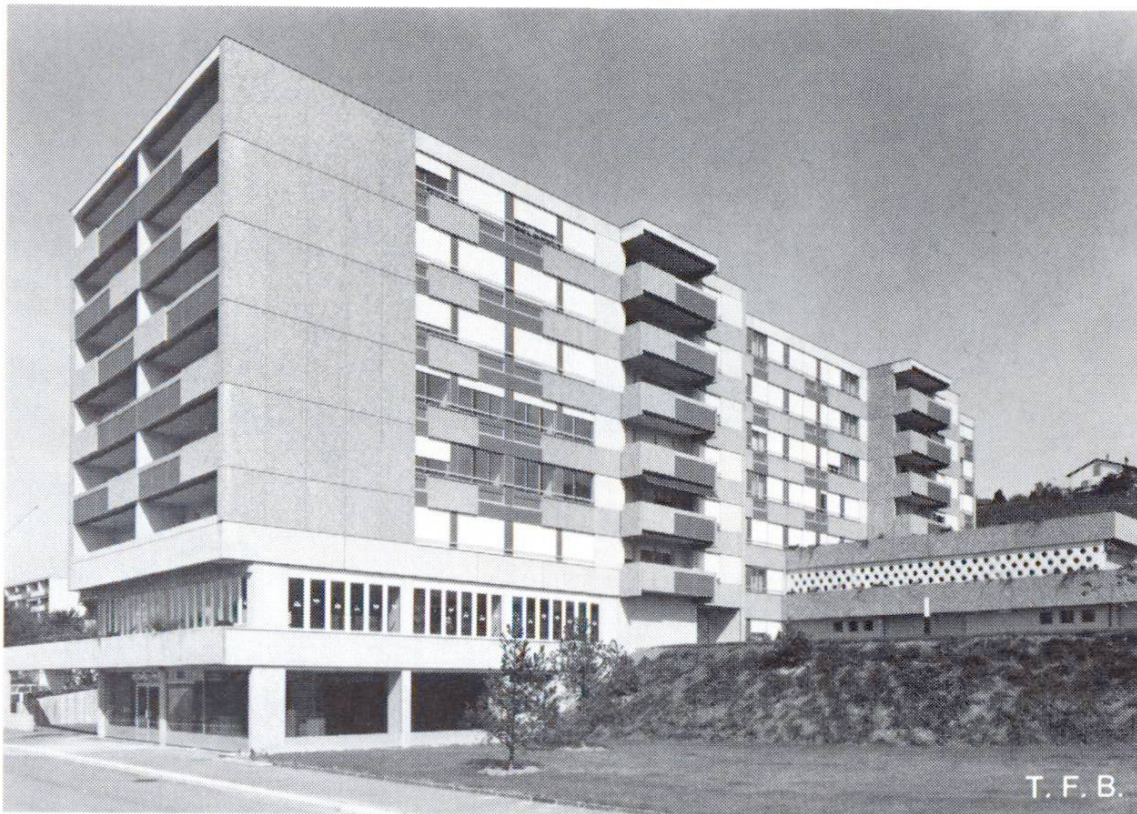
Fig. 7 Bâtiment locatif à Lutry. Béton lavé avec granulats de teinte foncée, combiné avec des dalles à coffrage en bois.
