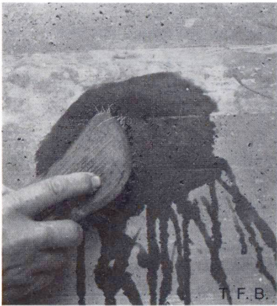
Fig. 11 La pâte desséchée est éliminée à la brosse puis à l'eau de savon.
