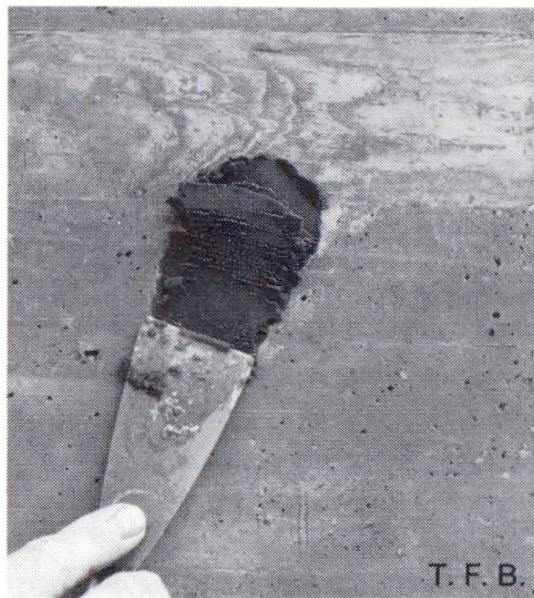
Fig. 4 La pâte absorbante est tartinée sur la tache.
