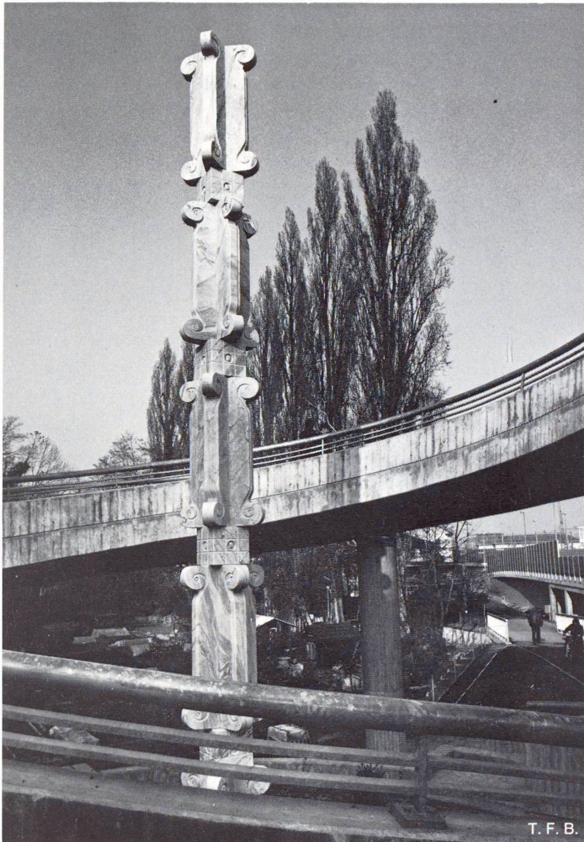
Fig. 6 La colonne d'allure fantasque forme un très beau contraste avec l'ouvrage en béton sobre et élégant.
