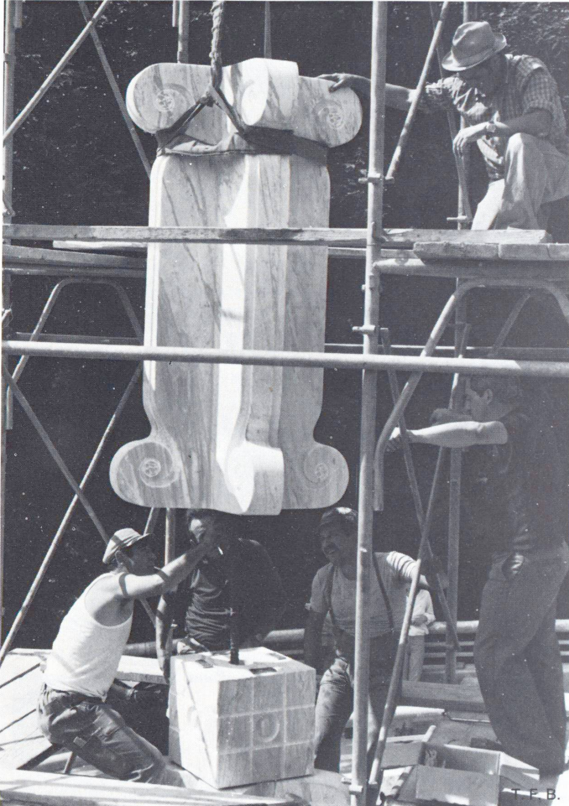
Fig. 4 Montage d'un des éléments de la plastique en marbre.
