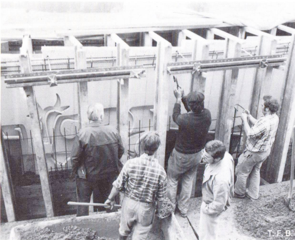
Fig. 3 Pour éviter d'endommager le moule fragile, on a utilisé des plaques de protection qui n'étaient glissées vers le haut que progressivement, au moment de la vibration du béton. L'armature, elle aussi, à été placée au fur et à mesure de l'avancement du bétonnage.
