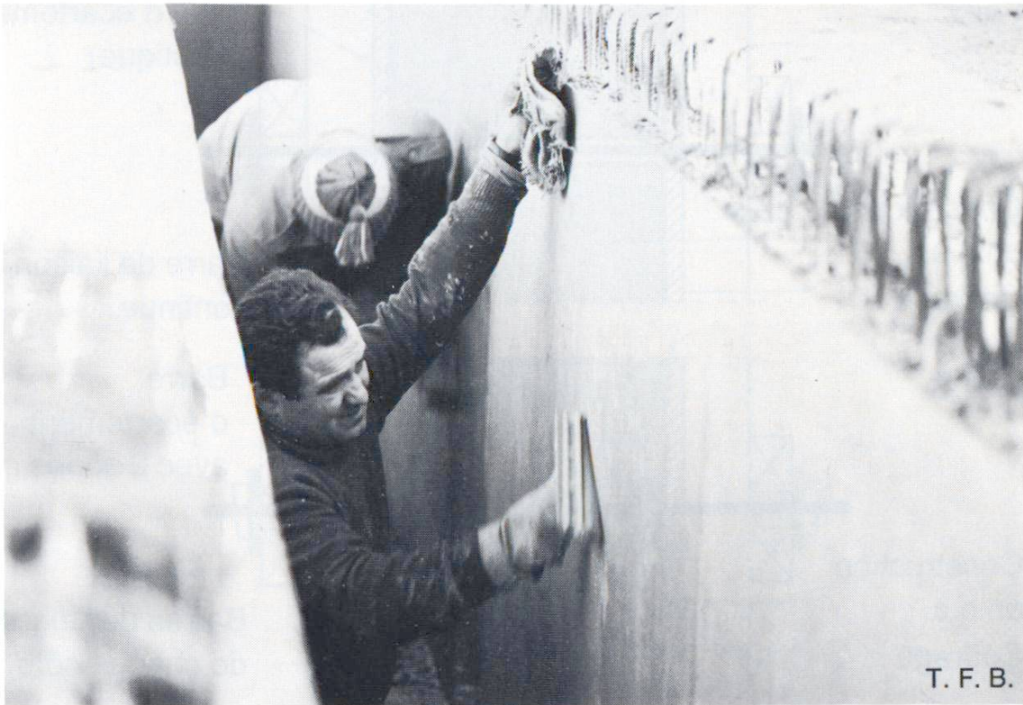
10. Traitement de surface au chiffon
