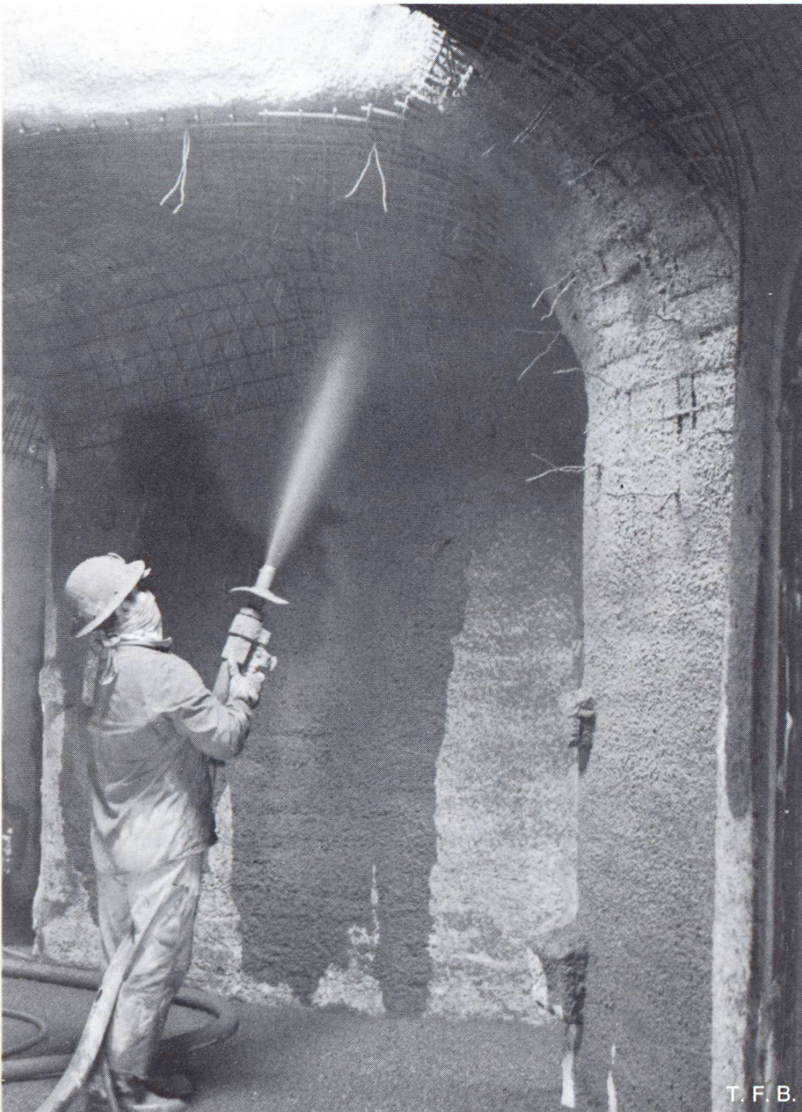
Fig. 5 Deuxième couche de béton projeté.
