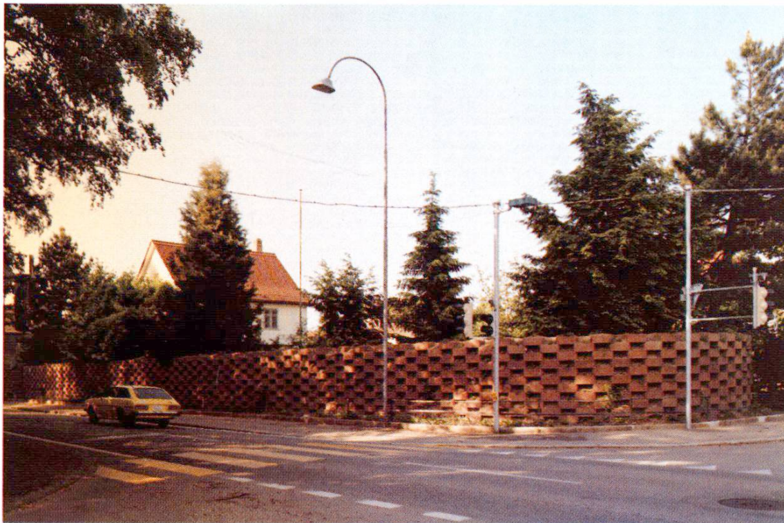
Fig. 3 Protection d'une villa contre le bruit d'un carrefour très fréquenté. Type L en éléments de 50 \times 20 \times 60 cm et 50 kg.
