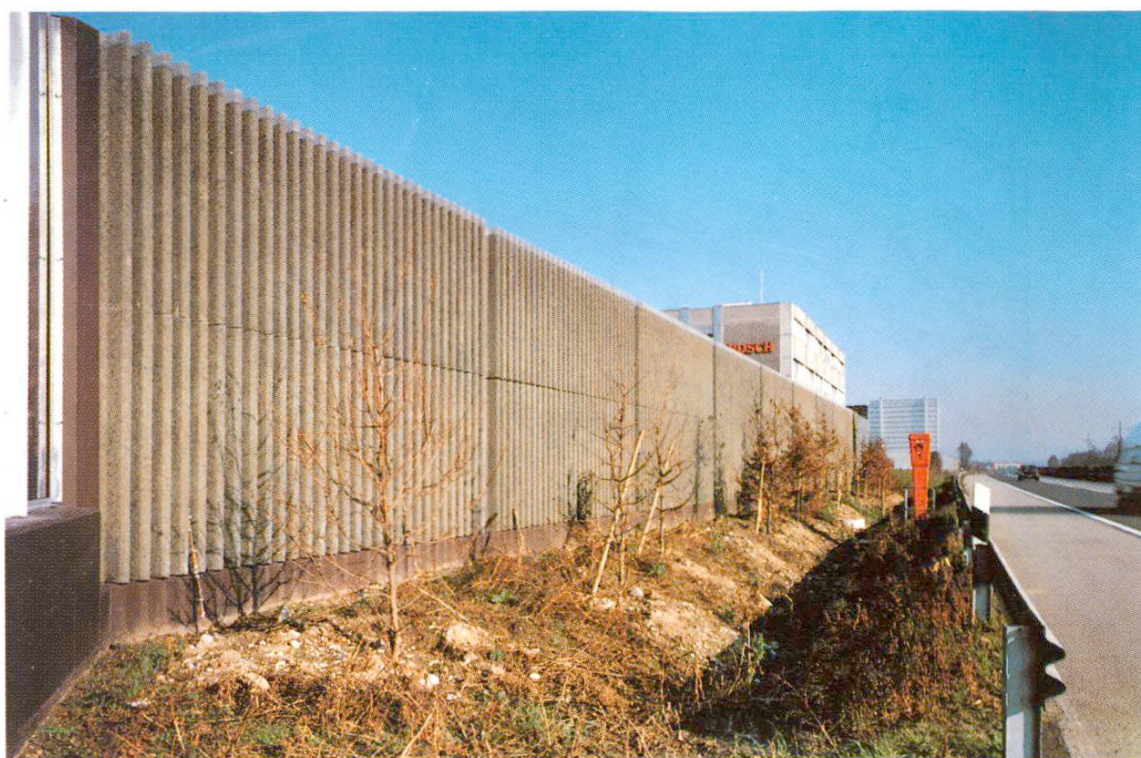
Fig. 8 Paroi antibruit le long de la N1 près de Lonay VD. Eléments type Structura en deux teintes (hauteur variable, longueur max. 5 m). Grand pouvoir d'absorption grâce aux nervures ou à une disposition genre palplanches. Les éléments inférieurs reposent sur une fondation en forme de gorge qui peut être en éléments préfabriqués ou bétonnée sur place.
