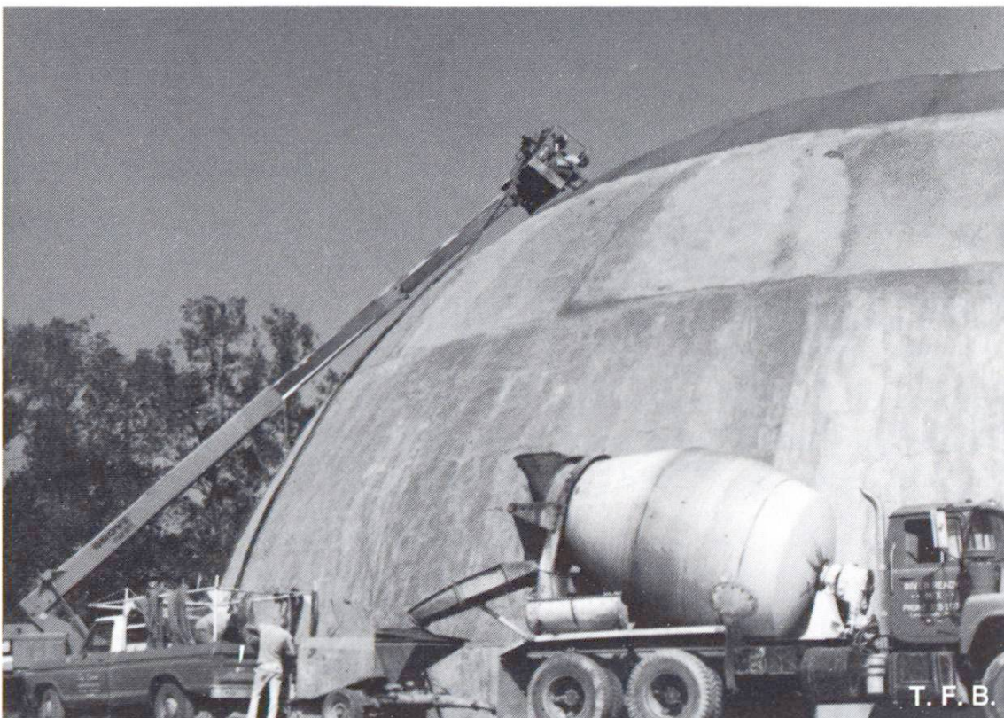
Fig. 9 Mise en place et talochage de la seconde couche de béton projeté. Une étanchéité sera appliquée ultérieurement.
