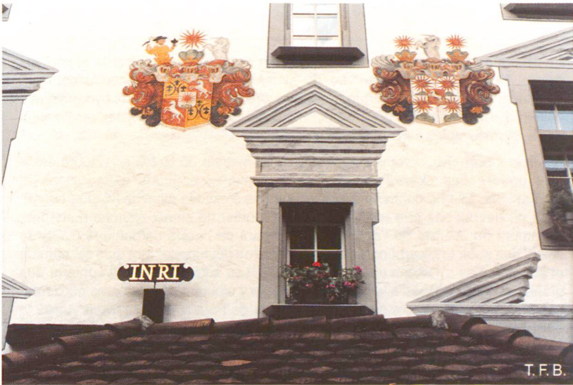
Fig. 4 Le crépi de cette façade a probablement été lissé à la truelle (Maison au Liebenau, Lucerne).
