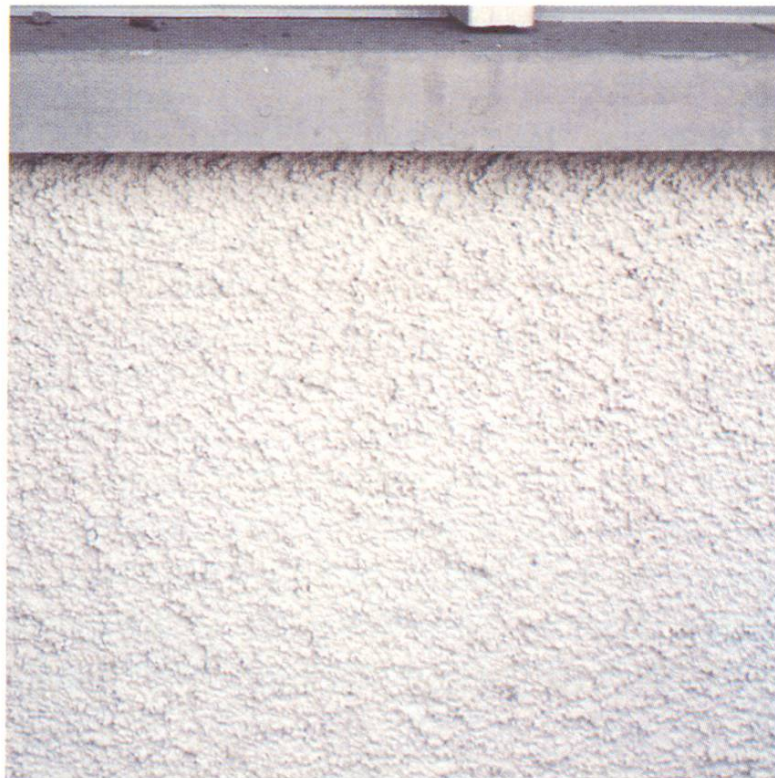
Fig. 14 Crépi de finition projeté à la truelle (Lindenplatz à Pfungen).
