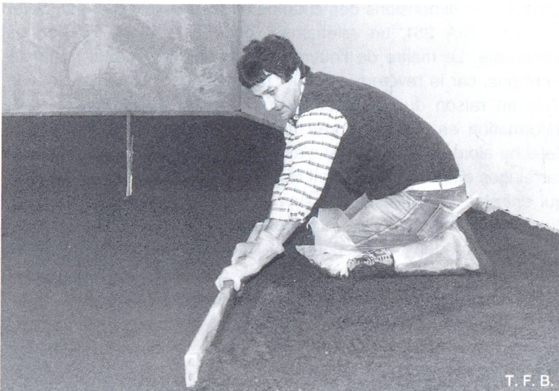
Fig. 3 Dressage du mortier au niveau prescrit.
