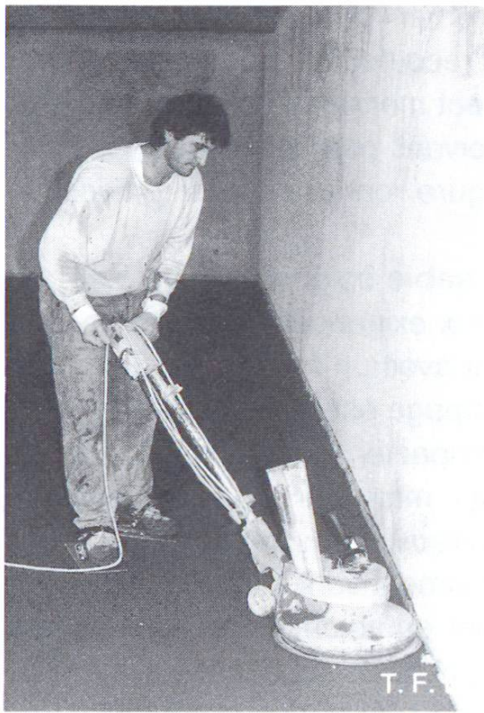
Fig. 4 Talochage à la machine à planer. On utilise généralement le disque.
