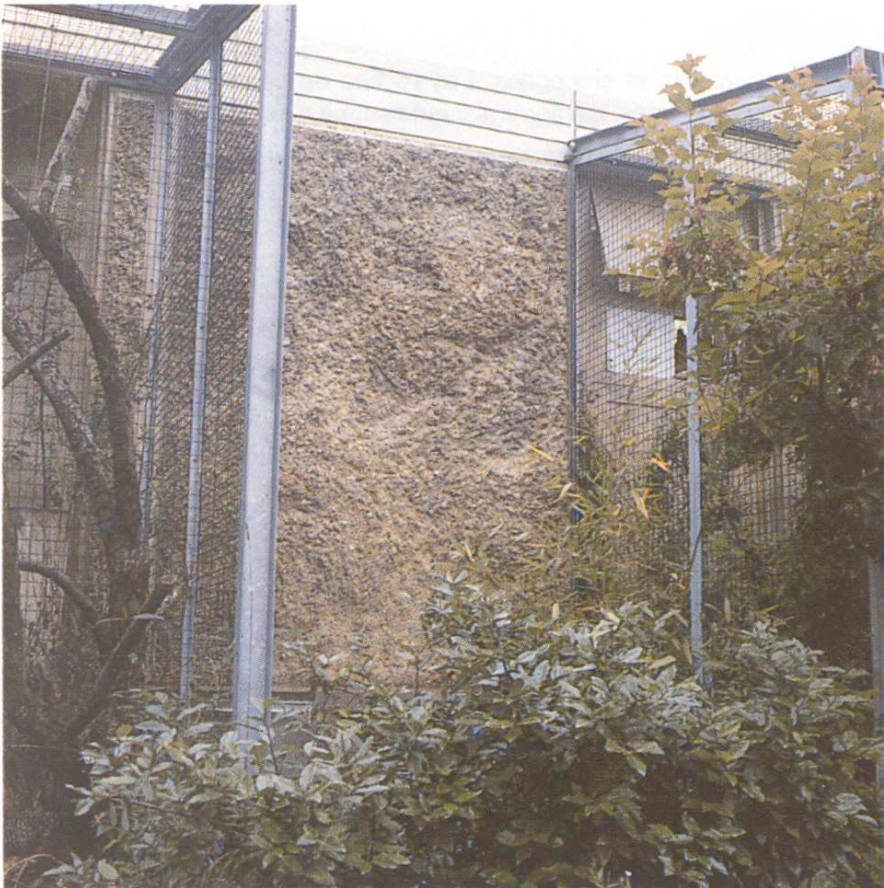
Fig.8 Eléments de façade préfabriqués en usine. L'arrière-plan semi-naturel remplaçant une surface de béton lisse offre aux oiseaux la possibilité de se percher et de nidifier.
