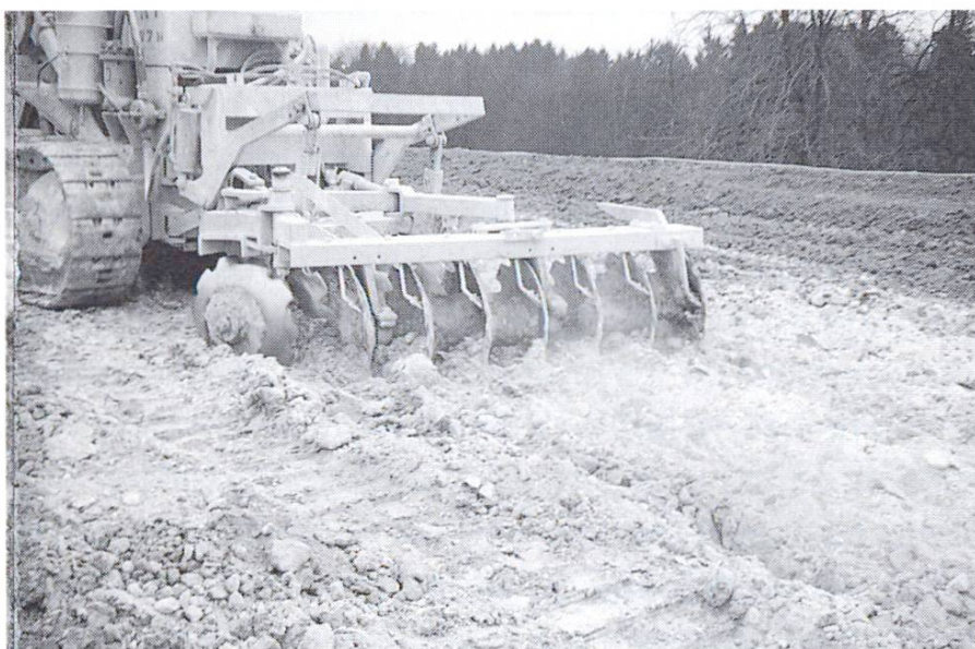
Fig. 13 Malaxage avec un pulvérisateur à disques
