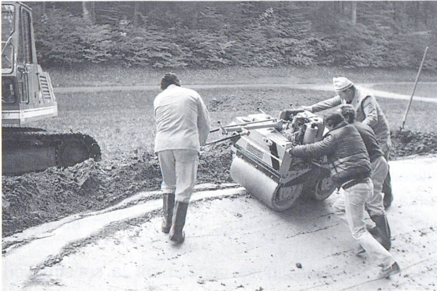
Fig. 15 Façonnage du bord
