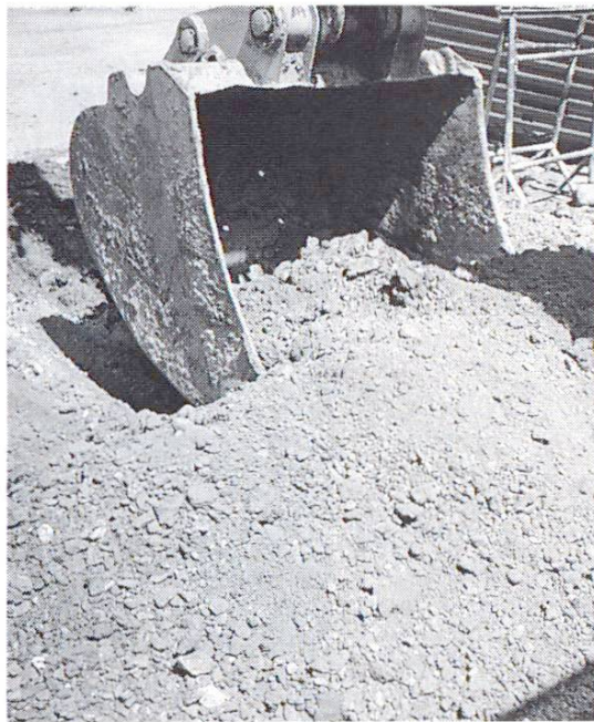
Fig. 3 Sol stabilisé à la chaux (maniable, grumeleux)
