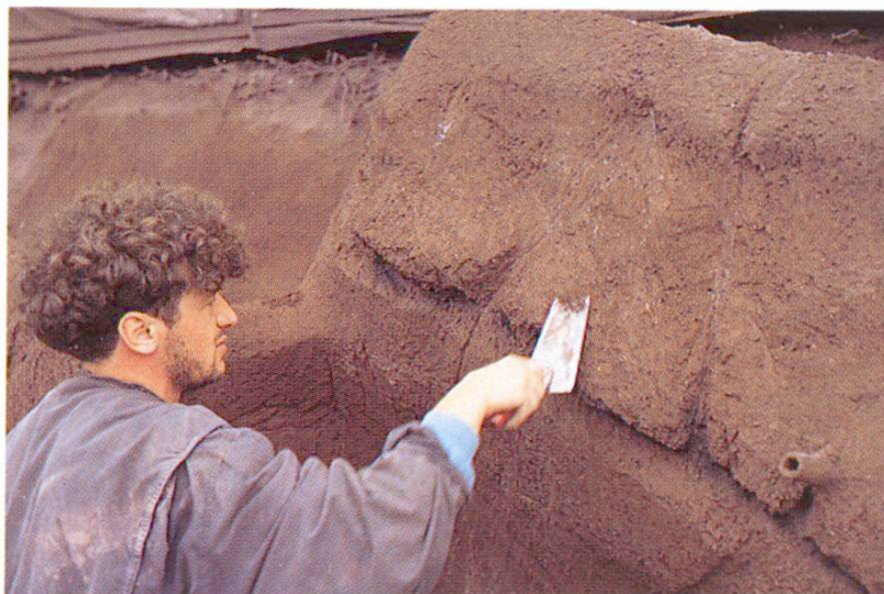
Fig. 11 Structuration (travail à la main)
