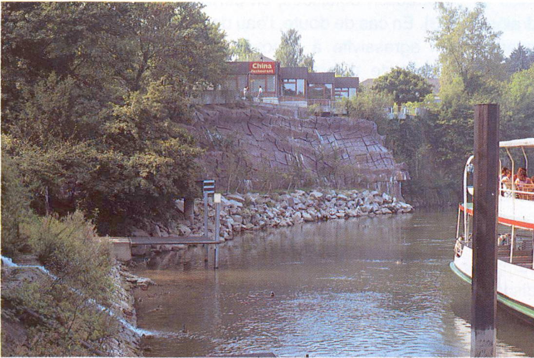
Fig. 2 Vue de l'escarpement rocheux stabilisé. Il se trouve dans une zone habitée, à proximité du débarcadère.
