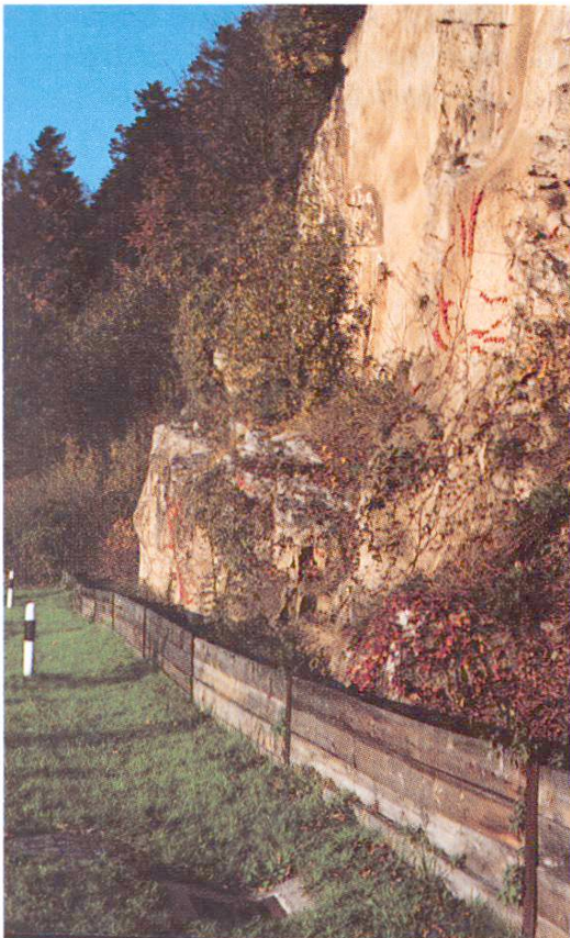
Fig. 13 Seules les parties menacées ont été stabilisées
