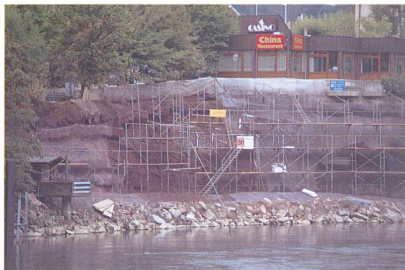
Fig. 10 Echafaudage pour la projection du béton
