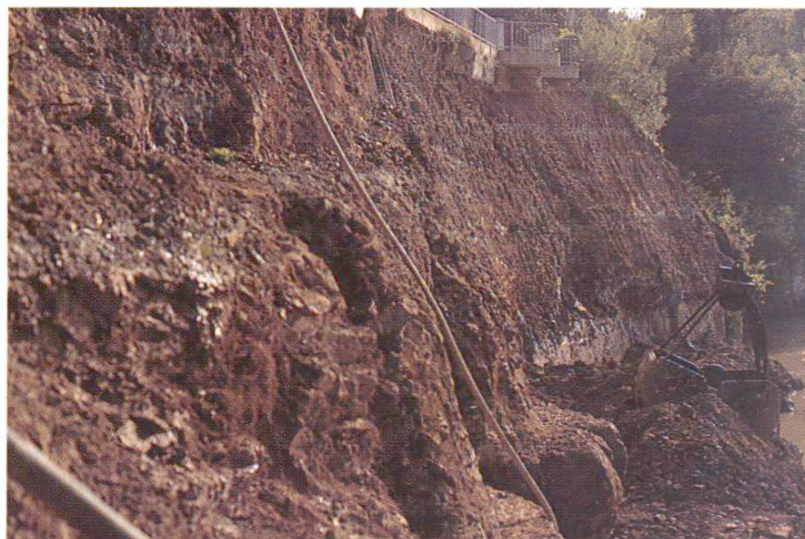
Fig. 9 Déblai (inclinaison variant!)
