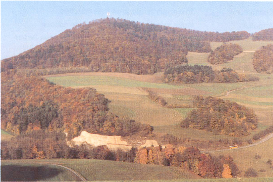
Fig. 12 Vue de la paroi rocheuse stabilisée. Elle se trouve en zone non habitée. Le déblai a été déterminé par le tracé de la route et, avant la stabilisation, consolidé par endroits seulement au moyen de treillis ancrés
