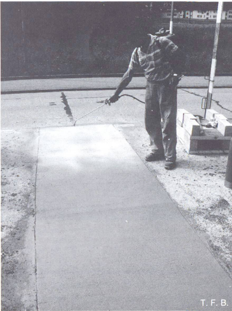
Fig. 5 Réfection d'un revêtement en béton. Traitement de cure sous forme d'application d'un compoud de cure. Commencement environ 5 à 15 minutes après le traitement de surface (c'est-à-dire dès que la surface est mate). Ensuite fig. 6.
