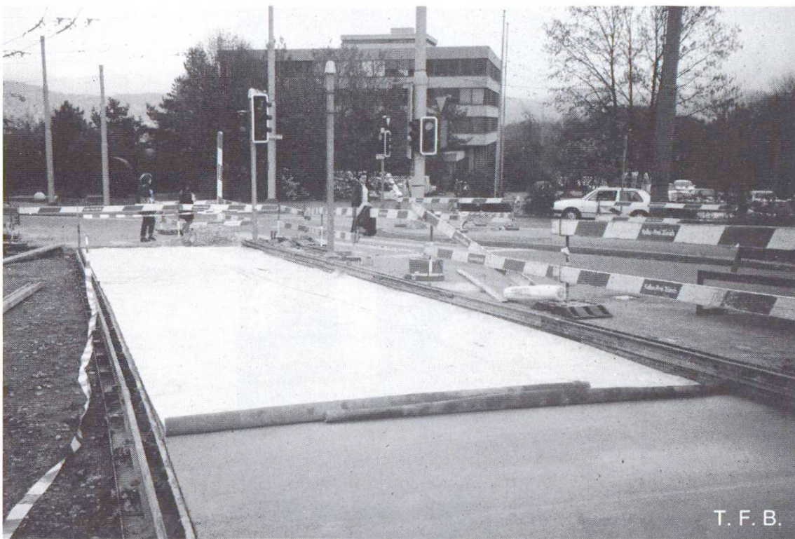
Fig. 4 Revêtement en béton pour un arrêt de bus. Traitement de cure avec compound de cure, puis recouvrement avec des nattes isolantes servant de protection (arrêt «Strassenverkehrsamt» à l'Uetlibergstrasse à Zurich, 1989).
