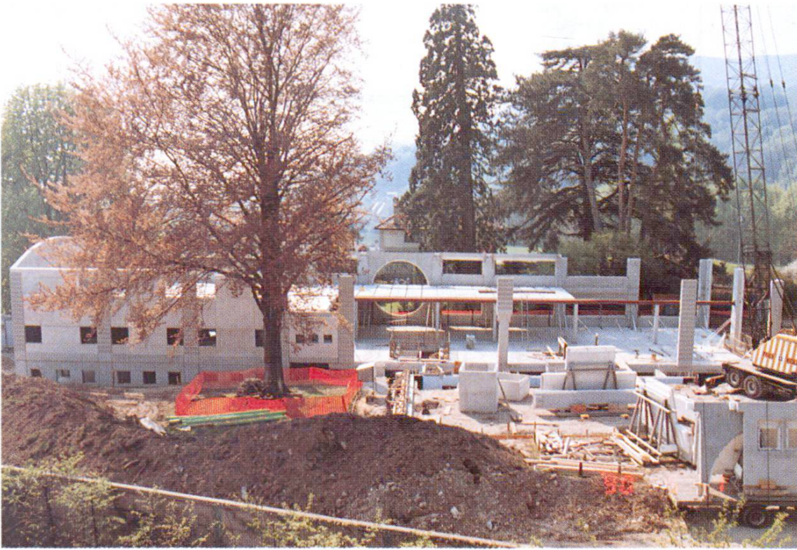
Fig. 5 Montage, vue d'ensemble
