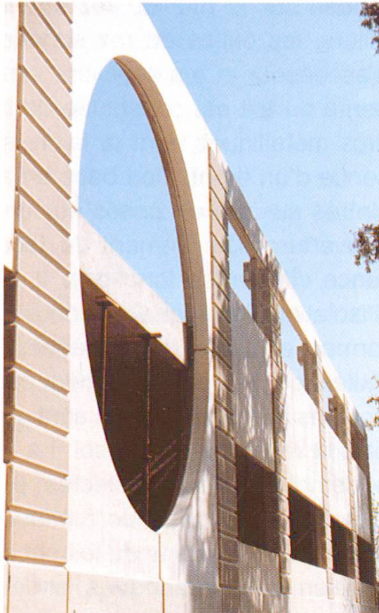
Fig. 8 Détail façade (ouest, côté parc)
