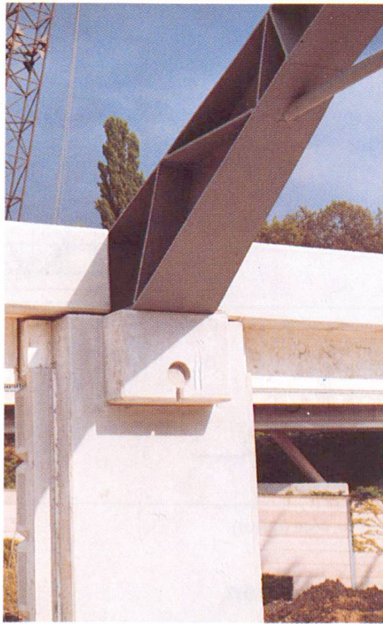
Fig. 7 Appui de la charpente métallique du toit
