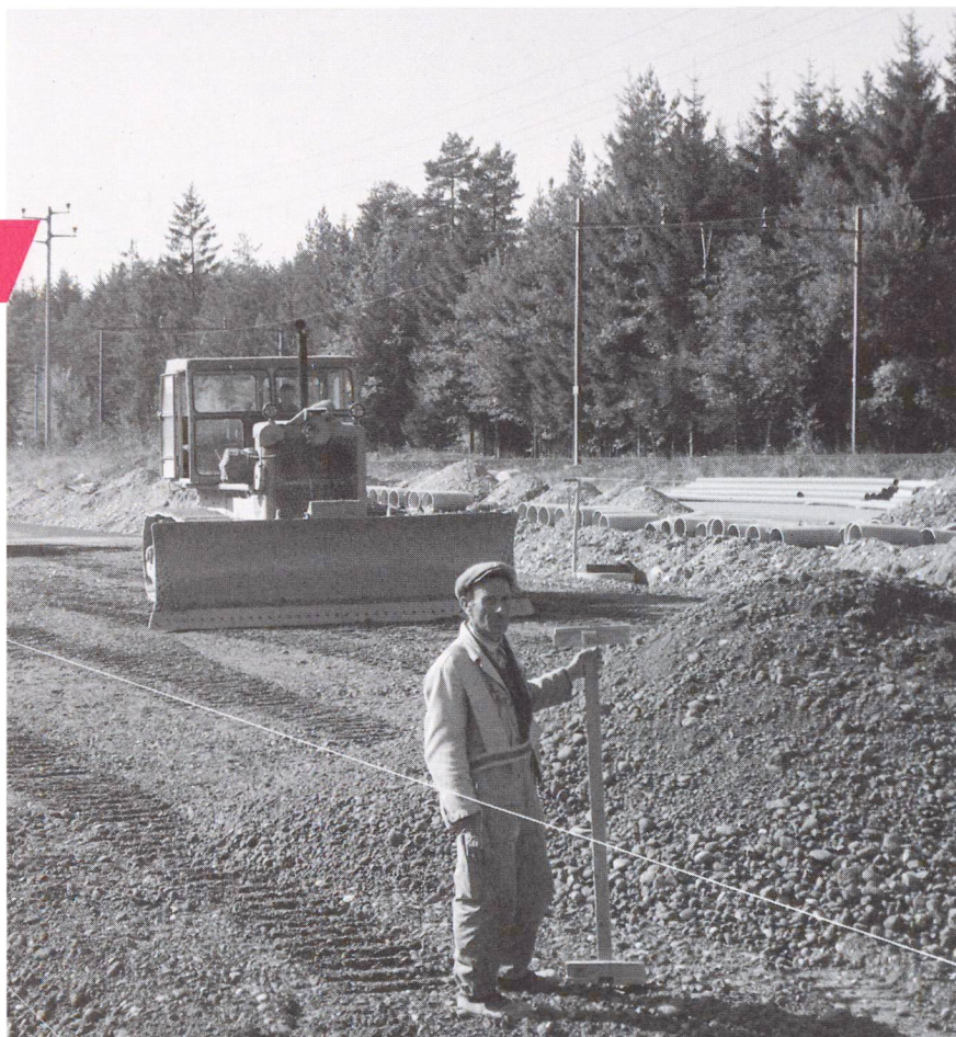
Nivellement au bulldozer.
