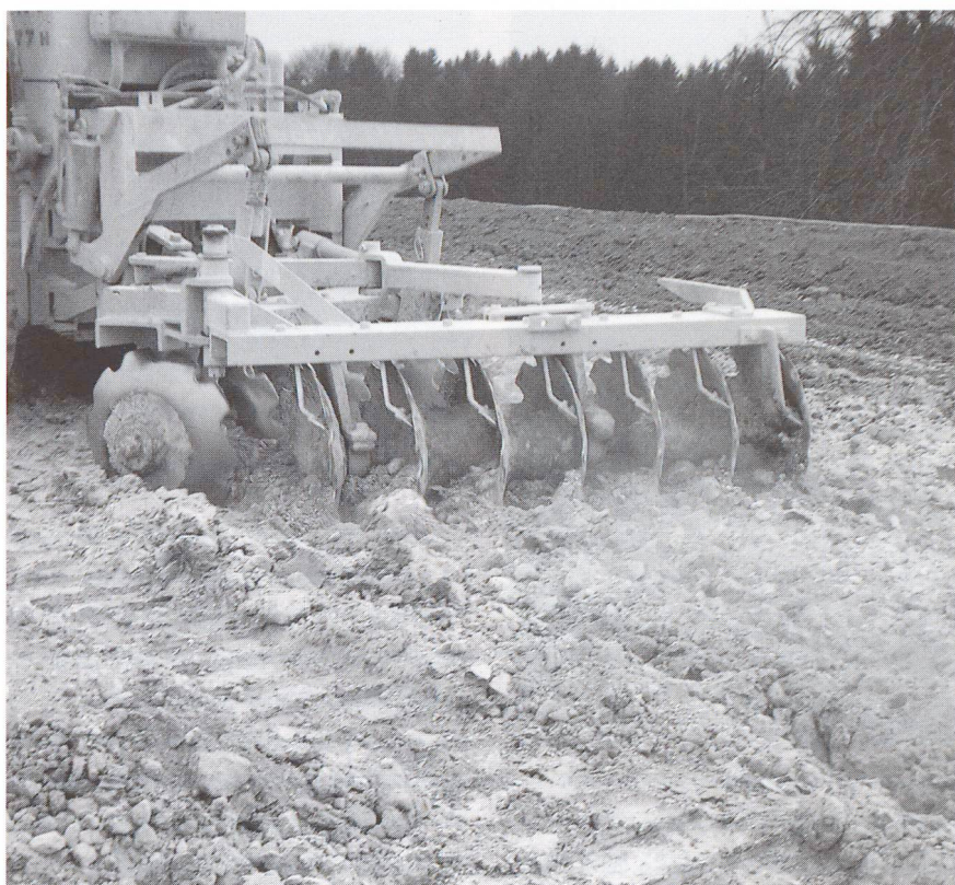
Incorporation du ciment au moyen d'une herse à disques.
