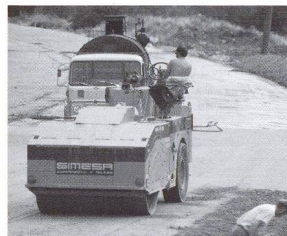
Compactage avec un rouleau vibrant.
