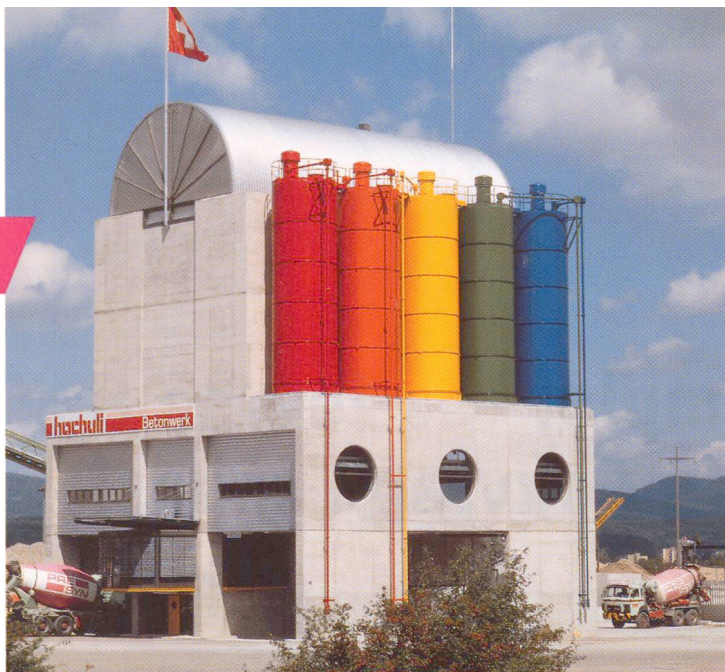
Centrale de béton prêt à l'emploi moderne.
