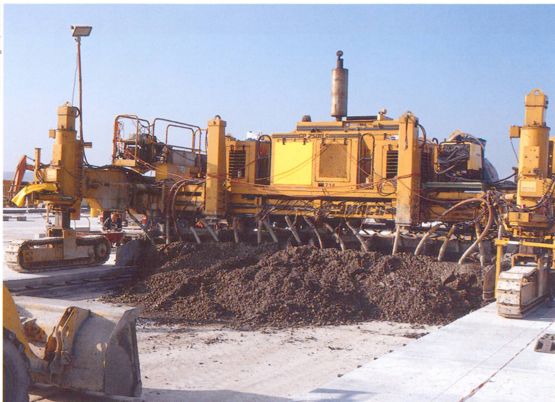
Mise en place avec finisseuse sur rails.
