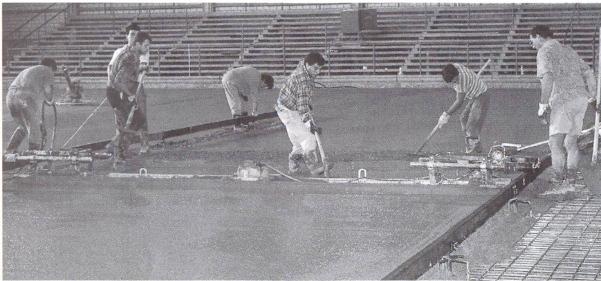
Mise en place du béton à la patinoire artificielle d'Aarau.
