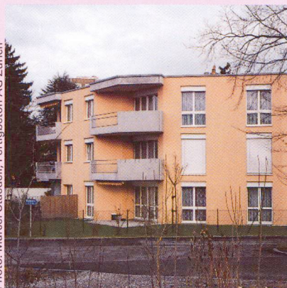
Photo: Marcel Staedeli, Fertigtbeton AG Zürich
