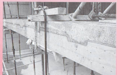
Zone des entailles après le bétonnage.
