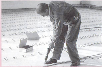
Mise en place avec un appareil de pose des éléments de liaison disposés par paire sur deux rangées.
