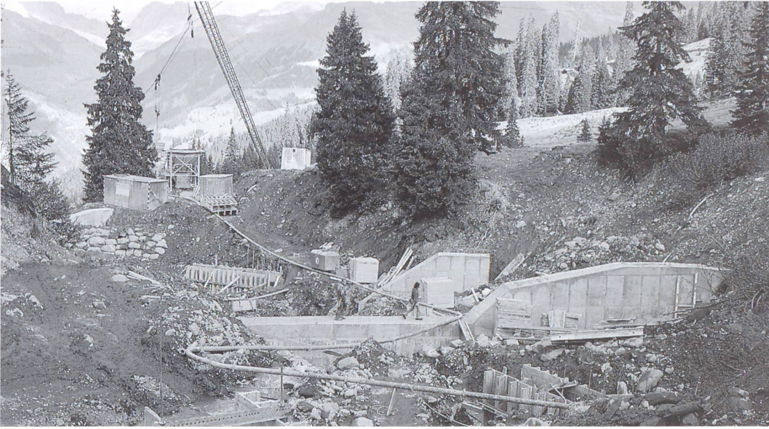
Correction d'un torrent: transport de béton pompé dans un terrain impraticable.
