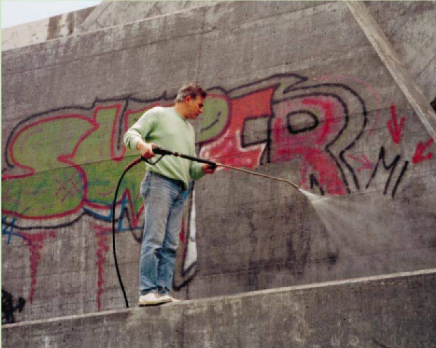
Elimination de graffiti sur du béton apparent prétraité avec une imprégnation et une couche de cire (couche sacrificielle).
