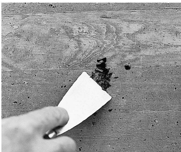
Fig. 2 On élimine un maximum de matière souillante avec la spatule.
