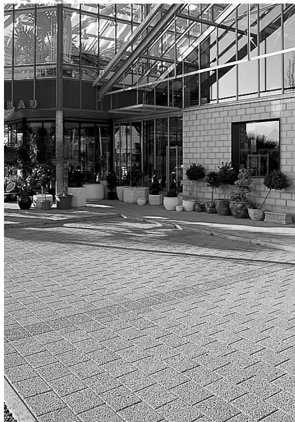
Pavés filtrants perméables à l'eau et à l'air en zone à faible circulation.
