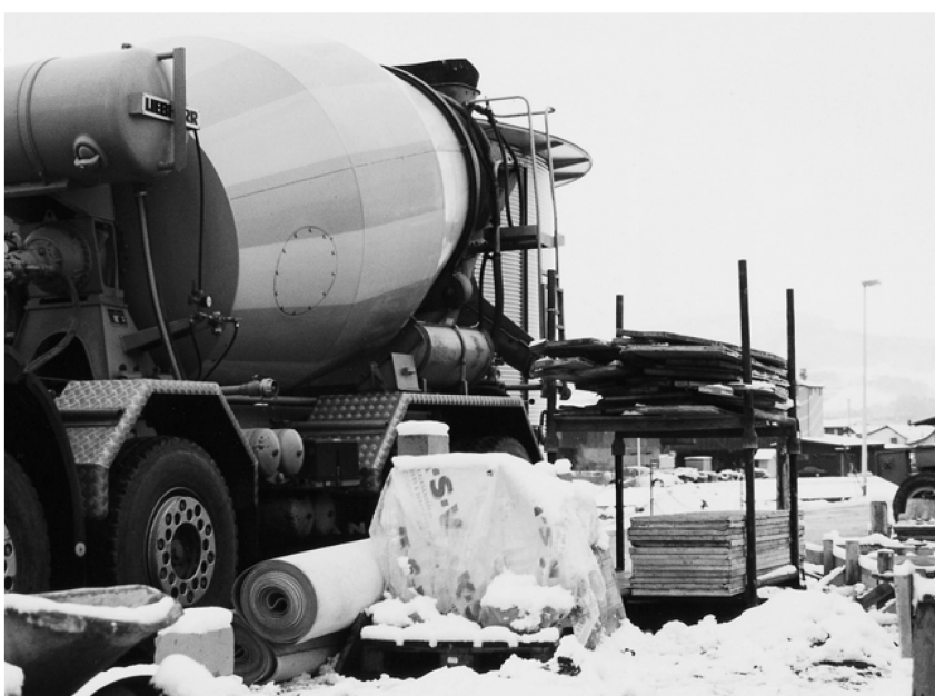
Le béton prêt à l'emploi est utilisable en toute saison, également en hiver, si l'on prend les mesures nécessaires [18].
