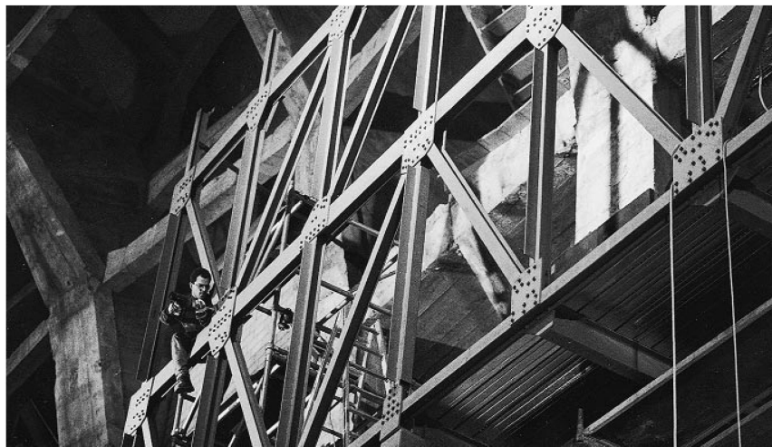
Fig. 4 Montage de la structure porteuse.
