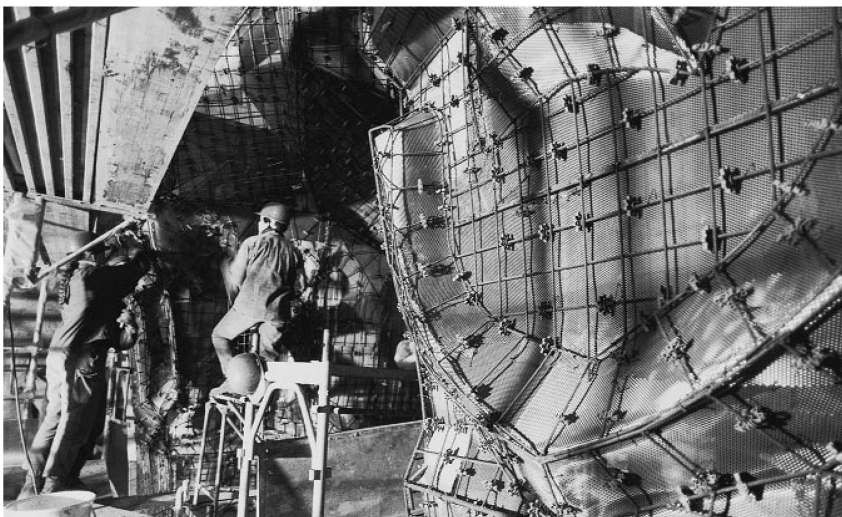
Fig. 6 Prêt pour la projection: métal déployé servant de «coffrage perdu» derrière le squelette en acier rond.
