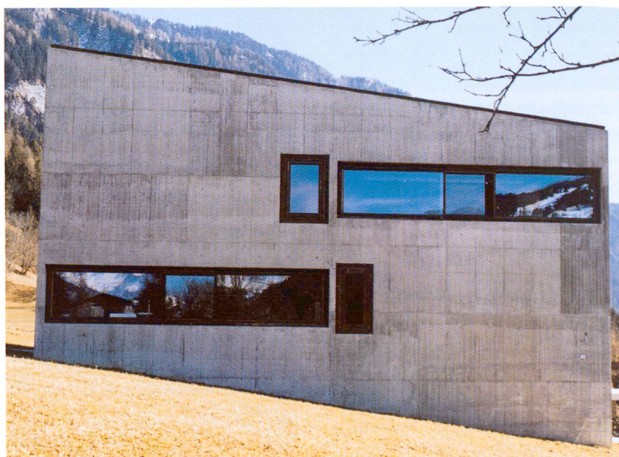
L'école de Paspels – le béton apparent par excellence.
