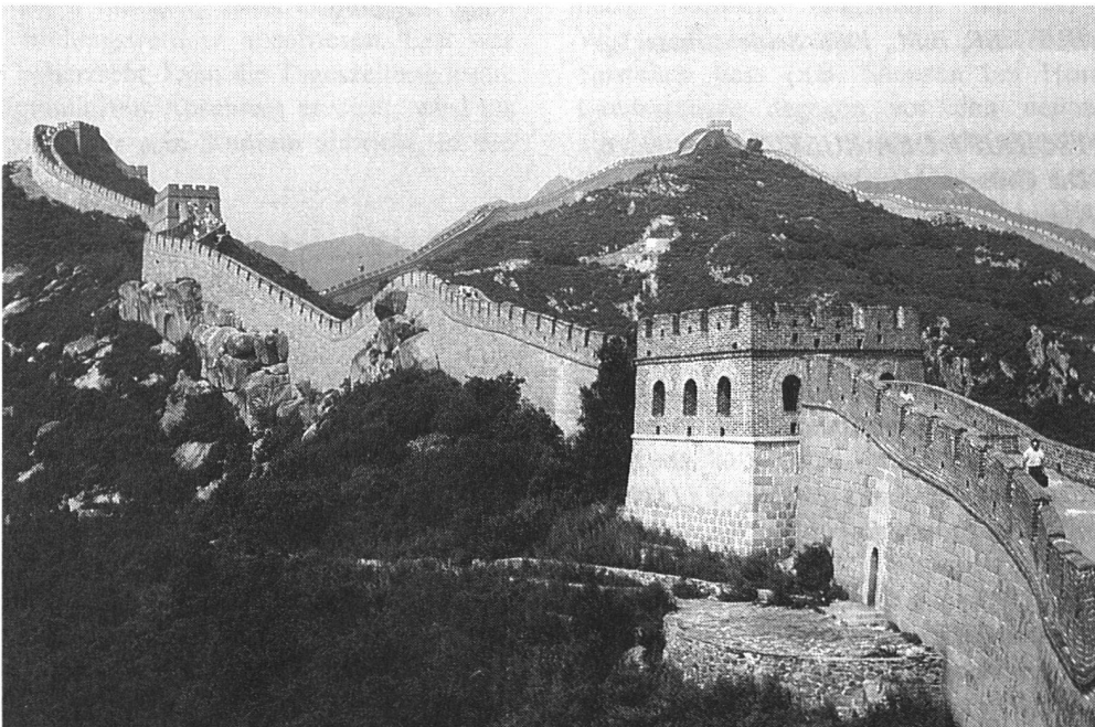
Abb. 5.: Die chinesische Mauer der Ming-Dynastie (1368 - 1644) nördlich von Peking. Hausteine umschliessen einen Kern aus Füllmaterial.
