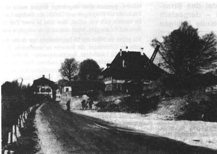
Abb 1: Erschienen am 2. April 1953 in den Emmentaler-Nachrichten: „Der gefährliche Engpass bei Rubigen verschwindet. Im Zuge des Ausbaues der Bern-Thunstrasse wird nun auch das Strassenstück durch das Dorf Rubigen verbreitert. Deshalb wird gegenwärtig die Stützmauer und das Peristyl des kürzlich vom Staat erworbenen Fellenberg-Schlösschens abgebrochen und damit der gefährliche Engpass am Südausgang des Dorfes, in dem sich immer wieder Unfälle ereigneten, beseitigt.“
