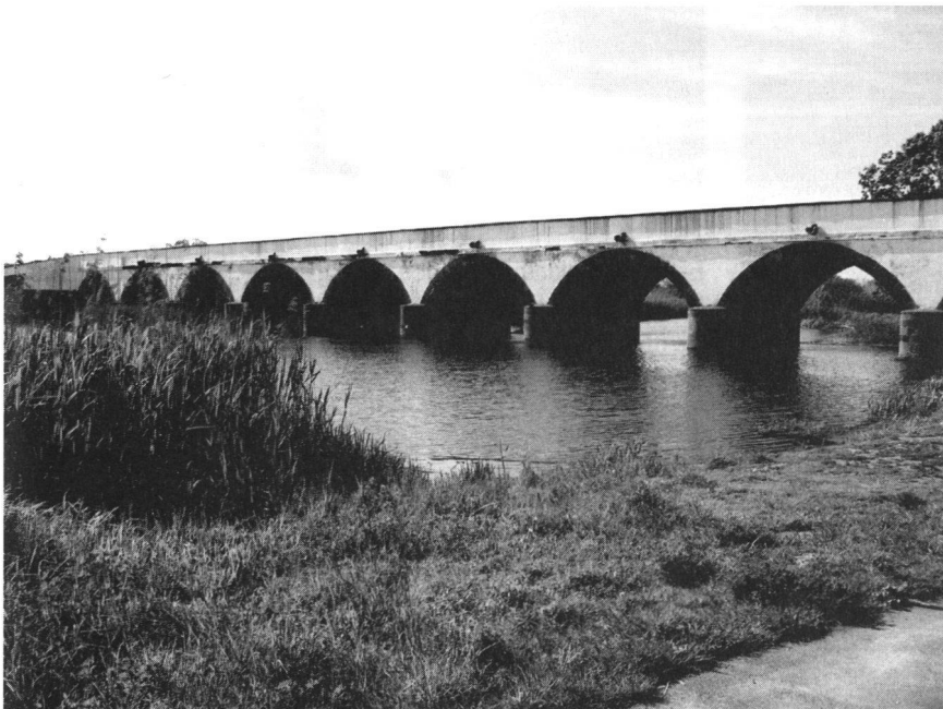
Neunbogenbrücke (Foto: Alfred Bretscher)
