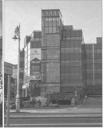
Abb. 6: Spekulationsbauten in den Doks von Dublin
