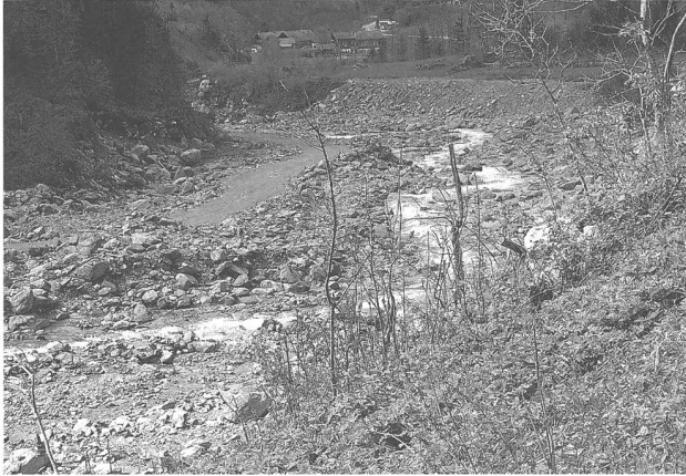
Abb. 2: Auflandungen der Murgänge aus dem Spreitgraben in der Aare. Der Weiler Boden und verschiedene Einzelgebäude sind durch zukünftige Murgänge aus dem Spreitgraben bedroht. (Foto Markus Zimmermann, 1. Mai 2014)
