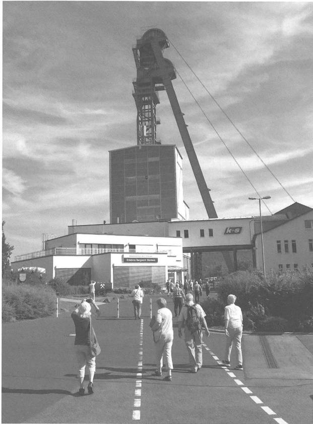
Abb: 3: Erlebnis-Bergwerk Merkers, Förder schacht (Foto: Matthias Giger)
