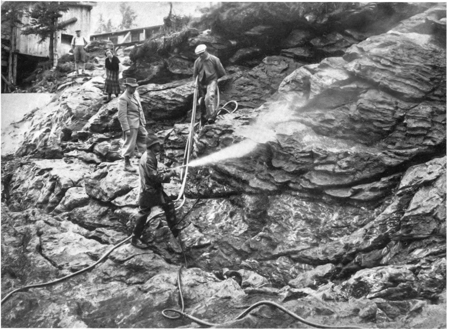
Abdichtungsarbeiten an der Felsverwerfung in der Nähe des Staudammes. Um die Oberfläche abzudichten, wird Zement in die Felsritzen gespritzt (siehe S. 223).
