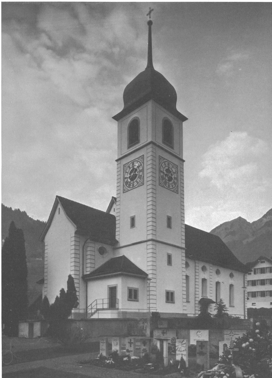
23. Gleiche Ansicht nach der Restaurierung
