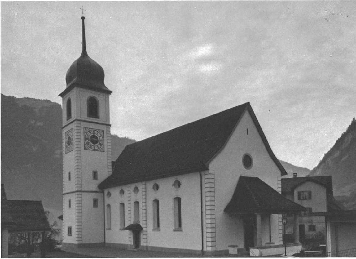
21. Gleiche Ansicht nach der Restaurierung
