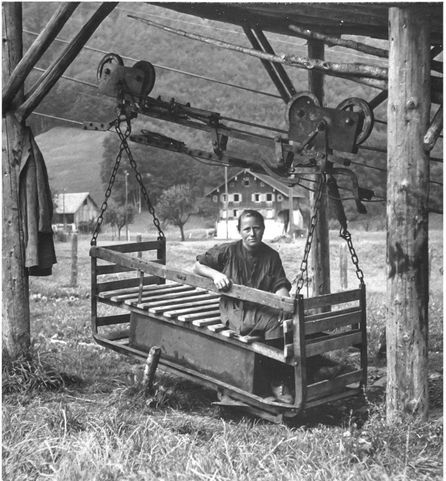
70 Seilbahnen überwinden auch das unwegsamste Gelände. 1909 wurde die Seilbahn Stegmatt-Vorder Diegisbalm als erste Anlage in Nidwalden erbaut. Heute besitzt Nidwalden eines der dichtesten Seilbahnnetze der Welt. 1981 verkehrten in Nidwalden 36 für Personentransport konzessionierte Seilbahnen und 85 Materialseilbahnen. Das Bild zeigt einen Karren der 1927 erbauten LSB Münchmatt-Büelen. Im Bähnchen sitzt Emma Aschwanden.
