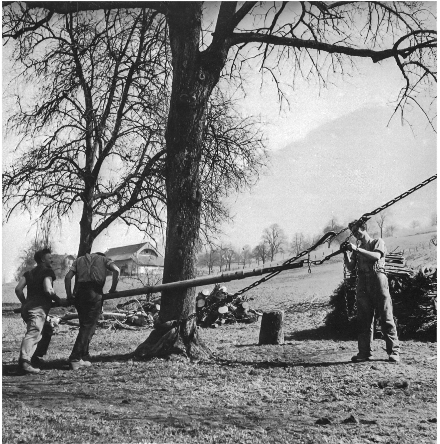
79 Drahtseile ohne mechanische Anlage und kostspieliges Rollmaterial sind ein ideales Transportmittel für Heu und Holz in schwierigem Gelände. Die Alpen und Bergheimen Nidwaldens sind mit Heuseilen dicht bespannt, 1980 waren zirka 200 Heuseile registriert. Drahtseile können mit dem erforderlichen Material von den Bauern selbst verankert und gespannt werden. Das Bild zeigt, wie ein Drahtseil mit dem Waldteufel, einer einfachen Einrichtung nach dem Prinzip des Hebelgesetzes, gespannt wird.
