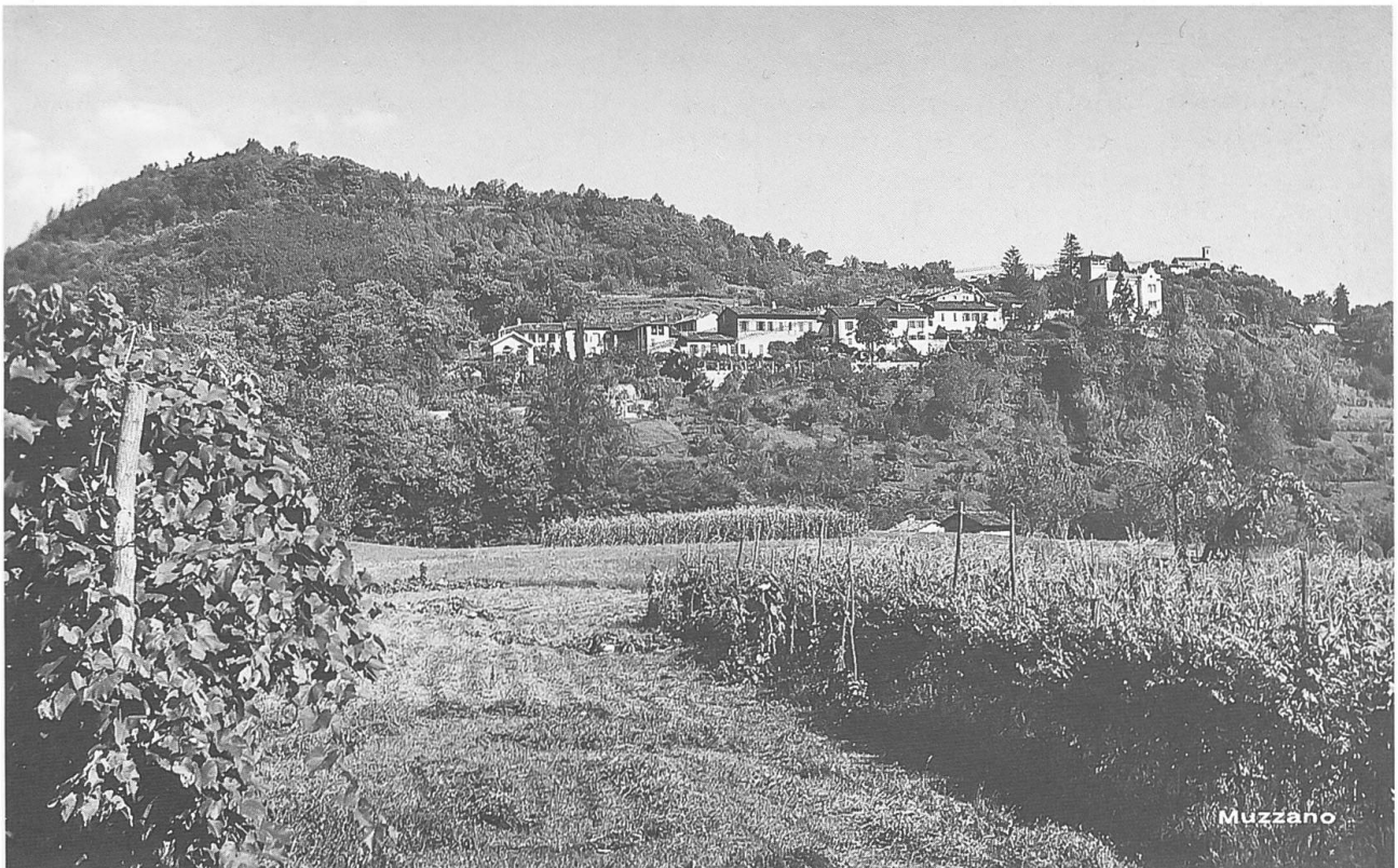
Fig. 1 - Il nucleo storico del Comune di Muzzano verso il 1950 visto dai campi attorno alla riva occidentale del laghetto di Muzzano. Al centro la casa Andreoli-Staffieri e il Palazzo Fe con i rispettivi ronchi.
