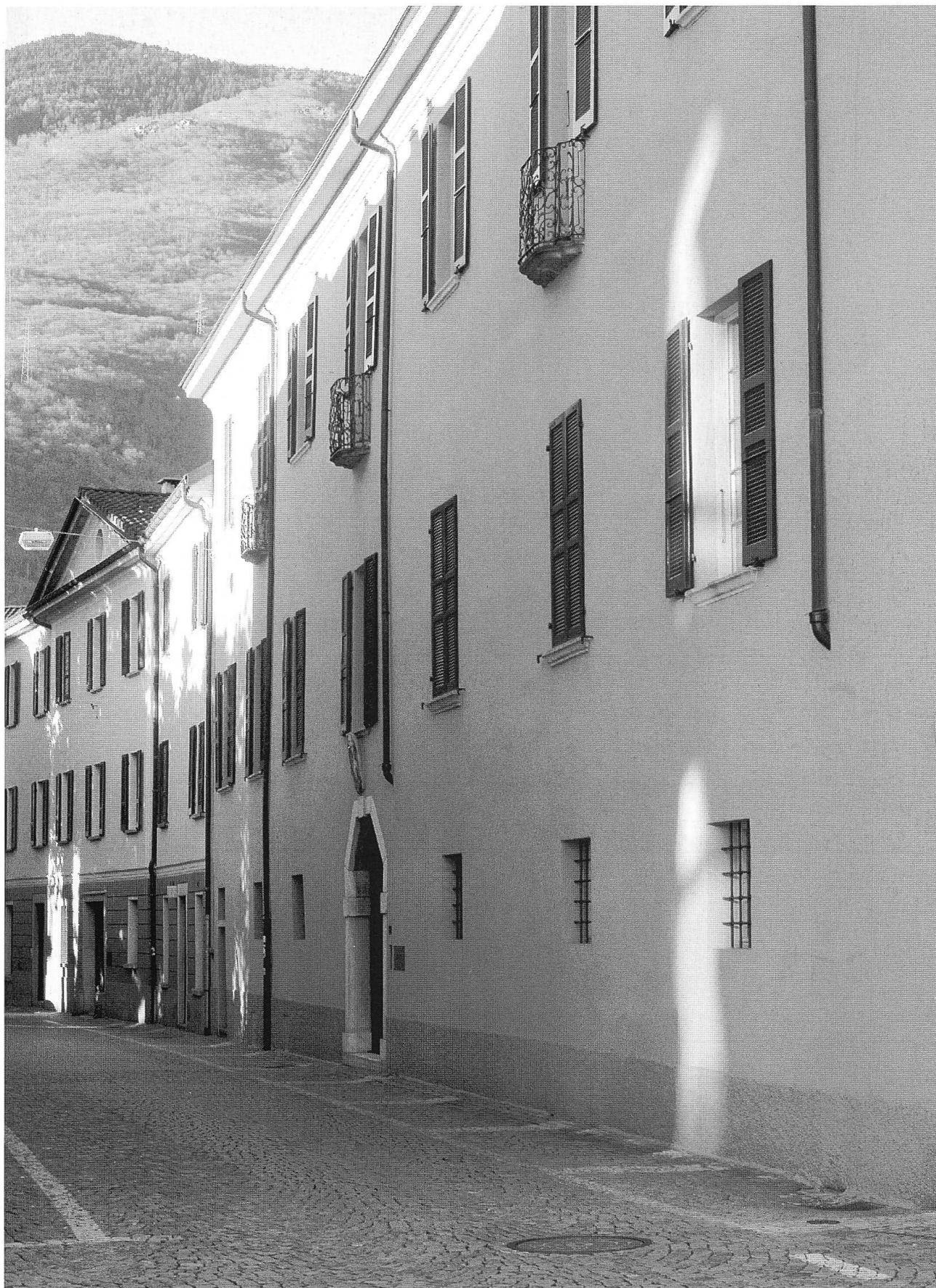
Facciata del palazzo Sacchi in via Orico a Bellinzona
