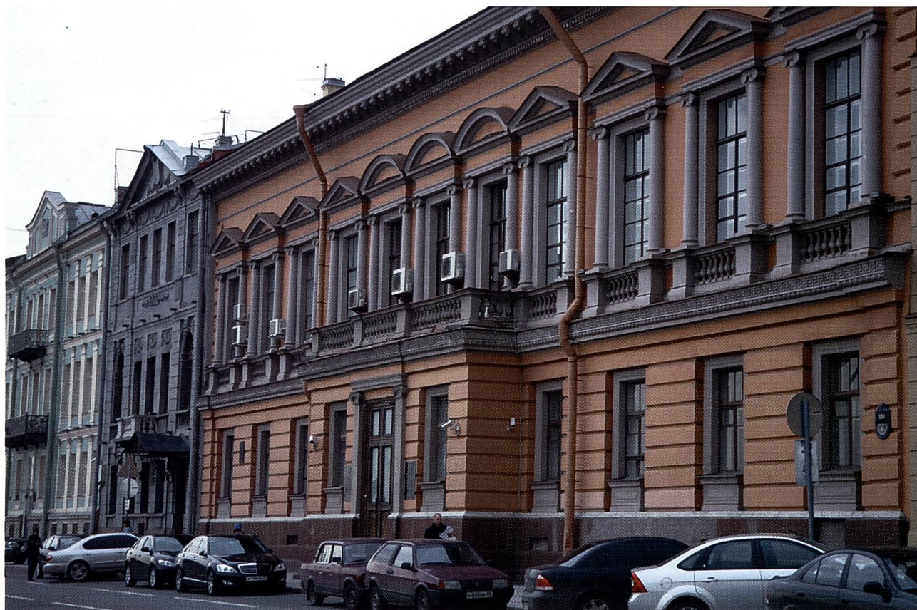
Foto 4 - Palazzo Durnovo, Quai des Anglais 16, 1872-1873
